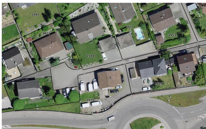
Abbildung 7 Gebaute Situation inkl. Grundstücke gem. amtlicher Vermessung (Luftbild gem. WebGIS Kt. Solothurn)
