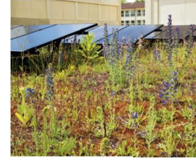
Dachbegrünung kombiniert mit PV
